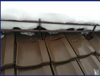
Unter Rohrhalter gebrochene Dachziegel (Bildquelle: Internet)
