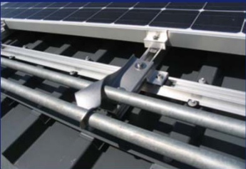
Verbogener Rohrhalter einer Aufdachanlage (Bild: Glaromat)
