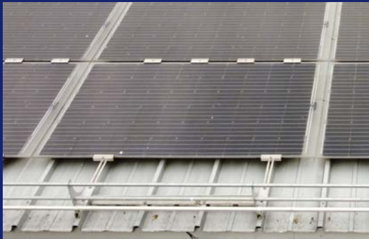
Aufdachanlage auf Stalldach mit Sandwichpanelen
