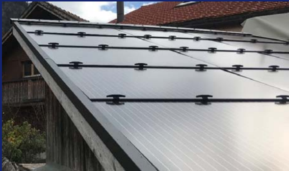
Schneehalter an kleiner Indachanlage
