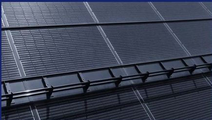
Beispiel: Schneefang mit erheblicher Verschattung gegen unten; Bildquelle: Solarmarkt
