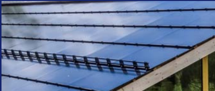
Beispiel: Schneefang mit erheblicher Verschattung gegen unten und oben (Westausrichtung); Bildquelle: CH-Solarpreis
