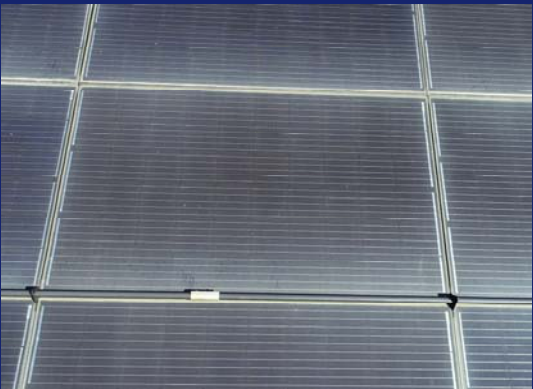
Grund: Schattenwurf durch ein zu nah befindliches Schneefangrohrs mit Muffe
