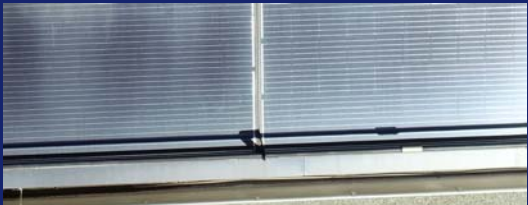
Grund: Röhrenschneefang an Traufe direkt an unterer Modulkante
